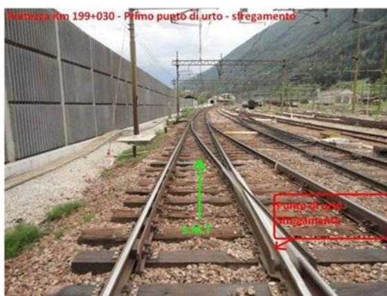
Figura 104 – Deviatoio 25 della stazione di Fortezza
